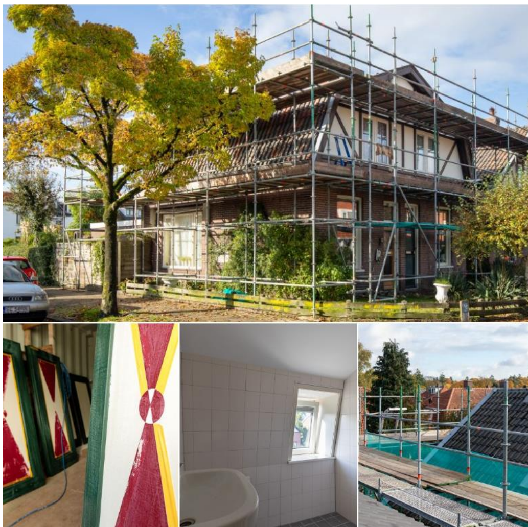
Verduurzamen en renoveren van monumentale jaren '20 woningen aan de Kritzingerlaan, Mickelerslaan en Dolderseweg
