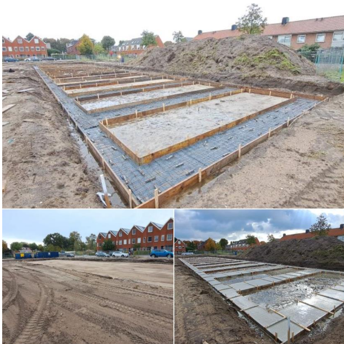
Fundament voor project Vederhof, waaronder 24 middeldure huurwoningen
