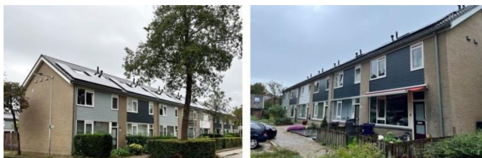
Resultaat renovatie eengezinswoningen Nijenheim 3000 en 6000 serie
